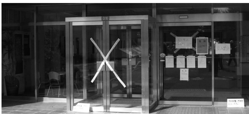
工学研究科電気系1号館で被災状況の確認
