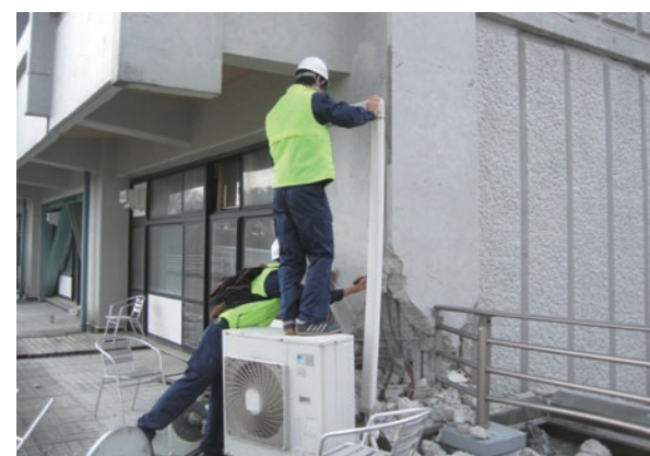
応急危険度判定の様子(写真提供/工学研究科都市・建築学専攻 前田研究室)
