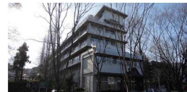
086、173:川内合同研究棟
