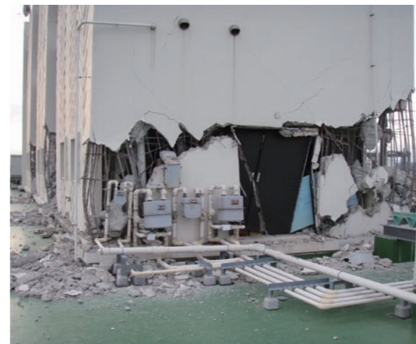
工学研究科電子・応物実験研究棟/棟屋の崩壊
