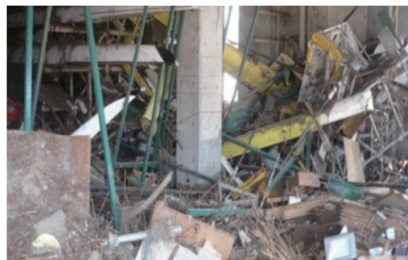
津波により、名取ボート艇庫施設内に進入した大量の瓦礫
