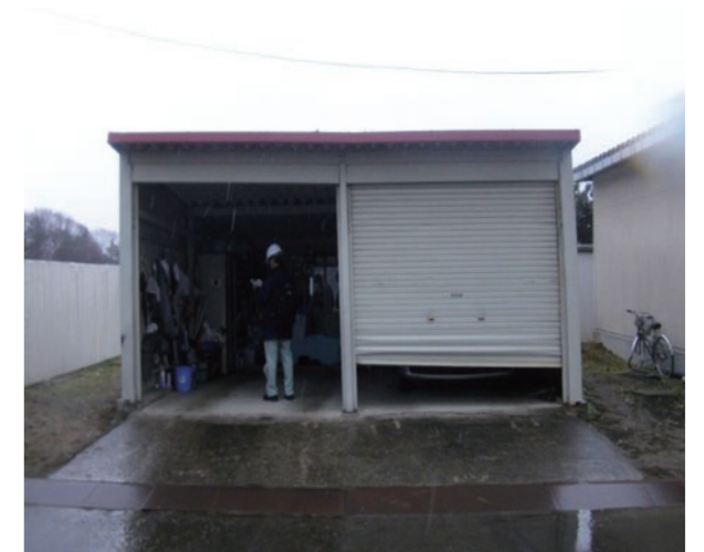
理学研究科車庫/不同沈下により建物全体が傾斜
