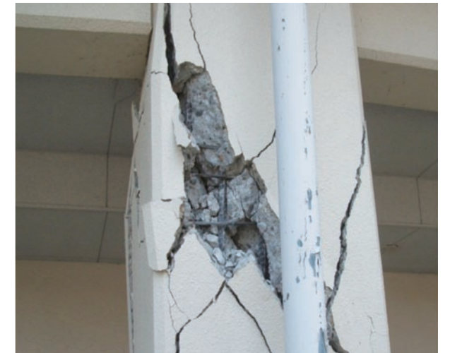
工学研究科電子・応物系北講義棟/外部柱のせん断破壊
