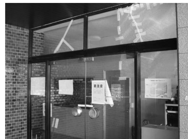
応急危険度判定で「要注意」判定された建物
