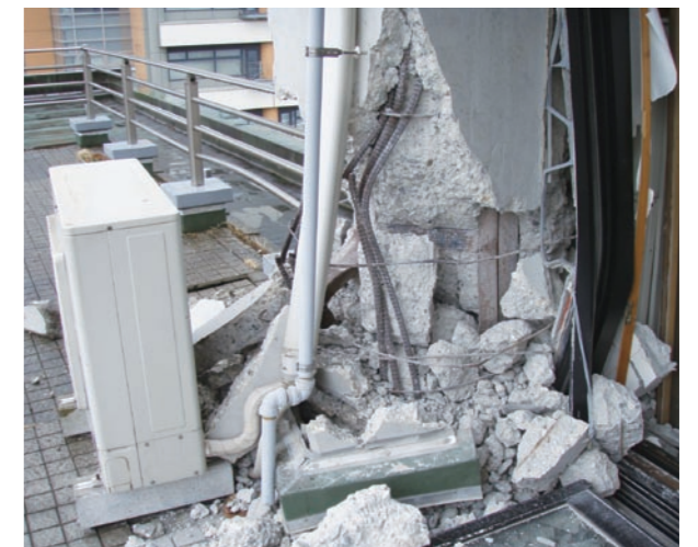
工学研究科人間・環境系実験研究棟/外部柱の圧壊
