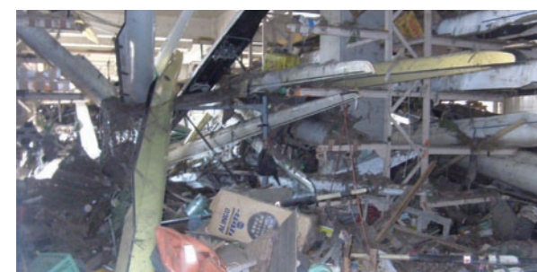
ボート艇庫・合宿所が津波により浸水し、建物内に大量の瓦礫が進入
