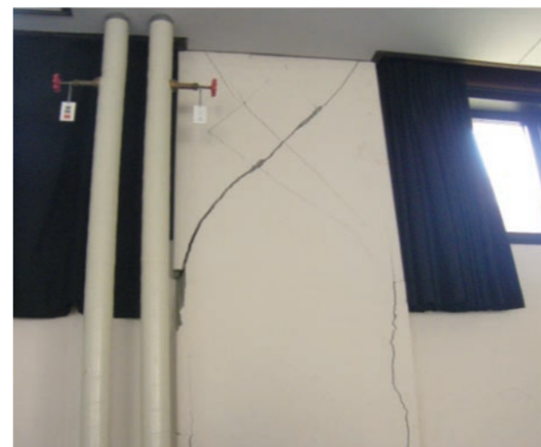
工学研究科マテリアル・開発系講義棟/柱のせん断破壊
