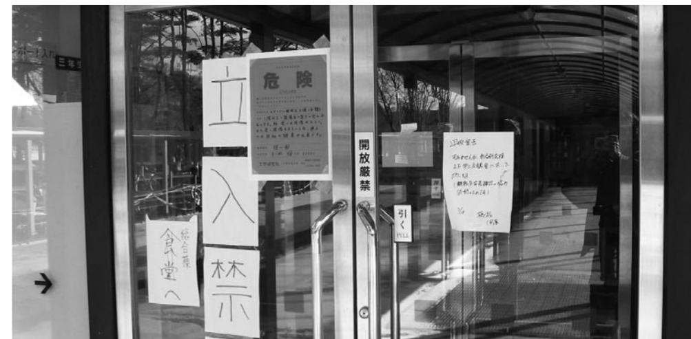
応急危険度判定で「危険」判定された建物
