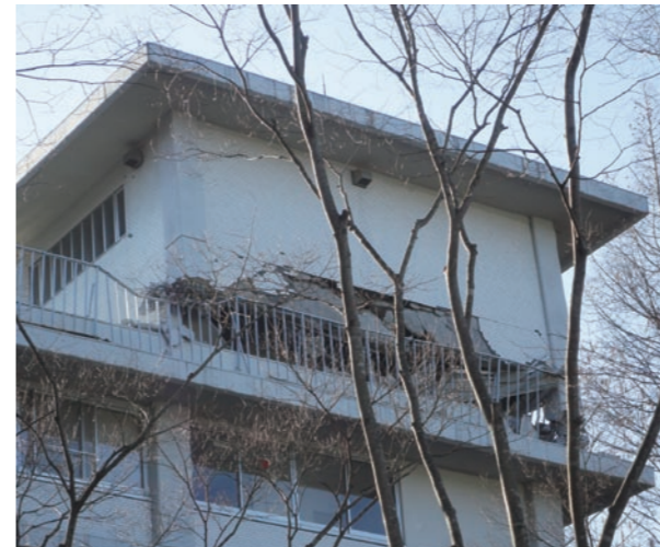
川内合同研究棟/棟屋の崩壊
