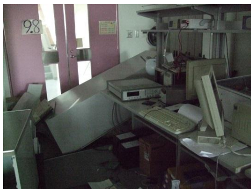
写真3 青葉山キャンパスにあった研究室での避難障害の事例（東日本大震災）
