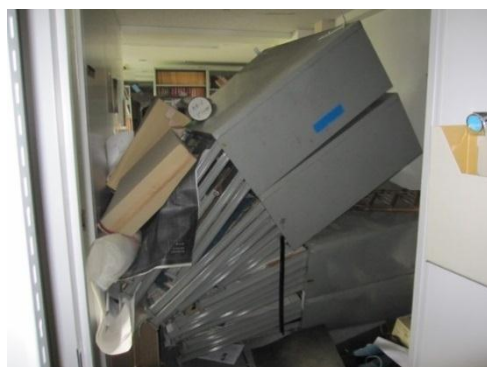
写真6 引き出し型の収納ラックの被害事例（東日本大震災）
