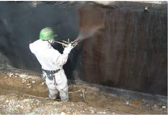
ゴムアスファルト吹付工法
