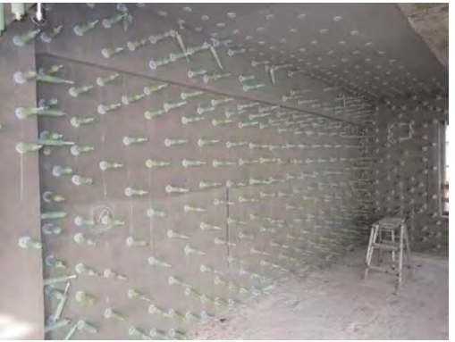
内圧充填接合補強工法
