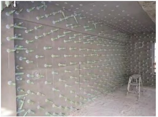
内圧充填接合補強工法
