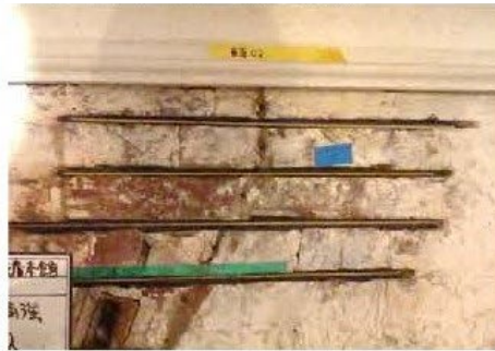
繊維補強材（アラミドロッド同等品） による縫合
