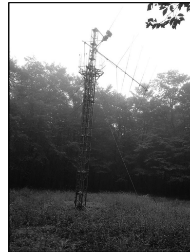
アンテナ支柱2
