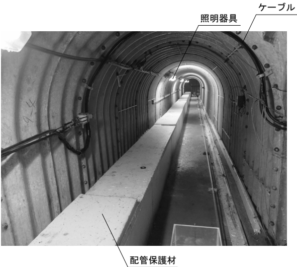
現地状況写真（観測壕内）
