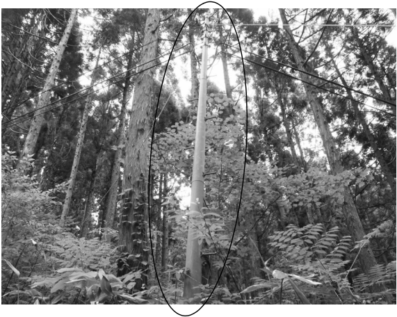
現地状況写真（電柱（パンザマスト）等）
