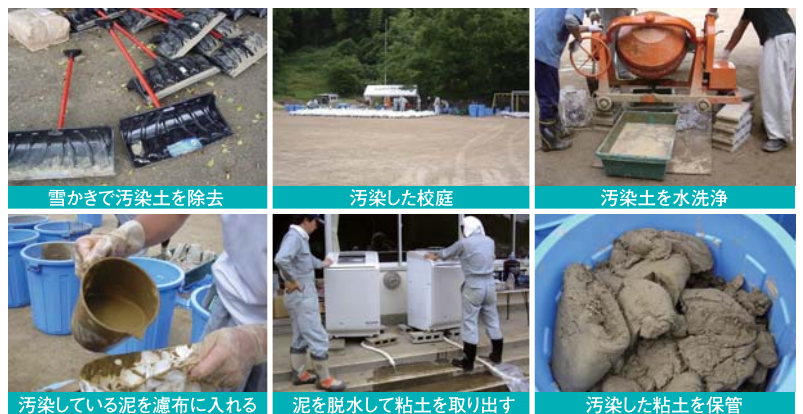
図2／宮城県丸森町耕野小学校の校庭の除染
