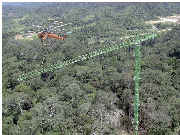
マレーシア連邦サラワク州に建設した林冠クレーン
