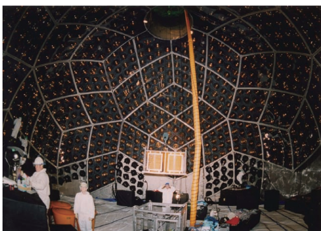
カムランド建設時の写真、直径50cmの高感度光センサーを直径18mの球内一面に取り付けている。
