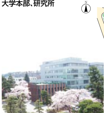
片平さくらホール(写真左)、材料・物性総合研究棟
