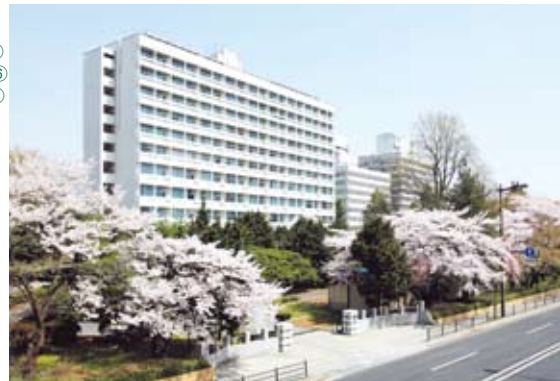
Gebäude der Hochschule für Aufbaustudien/Medizin
