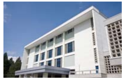
Bâtiment du Centenaire de l'Université du Tohoku (façade)
