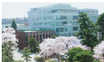
Edificio Katahira Sakura
