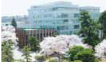
片平さくらホール(写真左)、材料・物性総合研究棟
