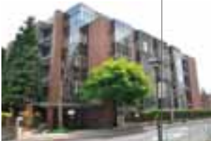
Vue extérieure du laboratoire
