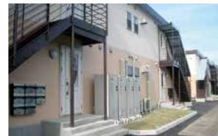
応急仮設寄宿舍外観（川内キャンパス）
