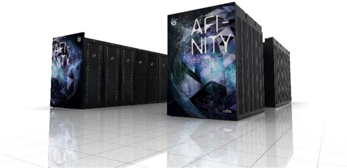
平成 30 年8月に新設された次世代融合研究システム”AFI-NITY(アフィニティ)“の外観
