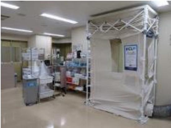
図 専用病棟の診療エリアの出入り口に設置された簡易式陰圧装置
