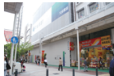
ビル建設中の旧しょんべん横丁
